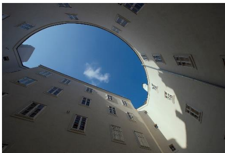
Innenhof im Narrenturm
